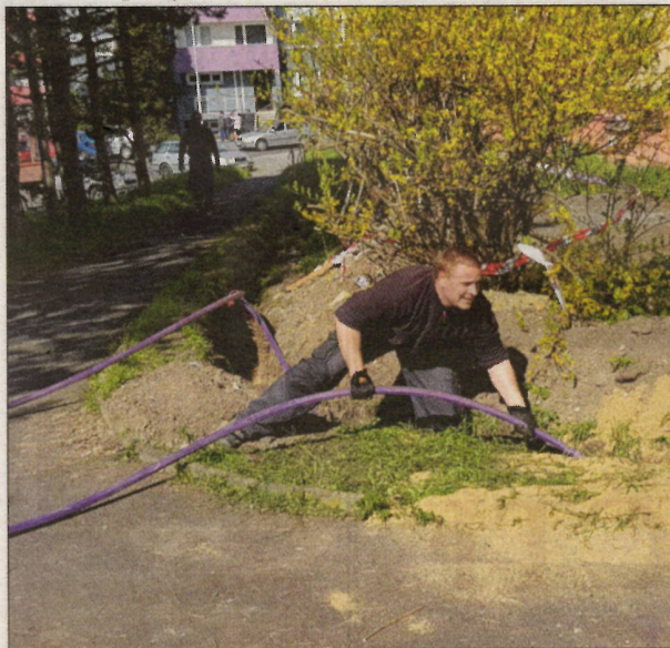
Jiří Rejha při tahání chrániček pro optické kabely na sídlišti Pražská.
